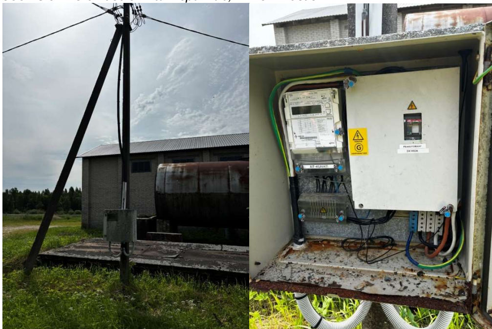
Joonis 3.1. Olemasolev liitumispunkt 0,4kV ÕL mastis.
